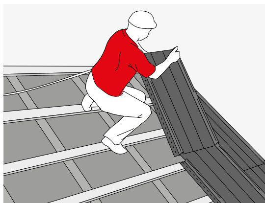
RYS. 23. ZAKŁAD PRZY ŁĄCZENIU PANELI NA DŁUGOŚCI
